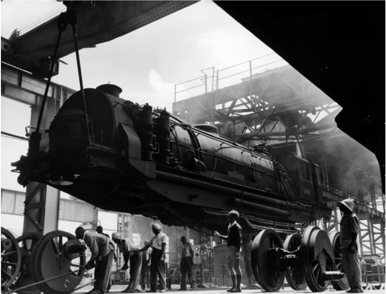
4. Zusammenbau einer Lokomotive in den Werkstätten der ostafrikanischen Eisenbahnen, Werbephoto eines unbekanntes Photographen für die East African Railways and Harbours Administration, Nairobi, Kenia, ca. 1960, 2002/133/1/34 © Bristol Culture/British Empire and Commonwealth Collection.
